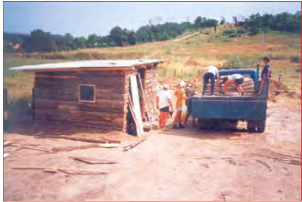
Megérkezett a cement
