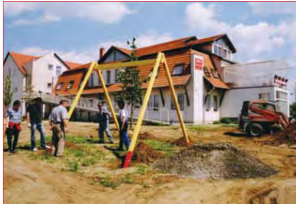
Épül a játszótér a fogyatékos gyermekeknek
