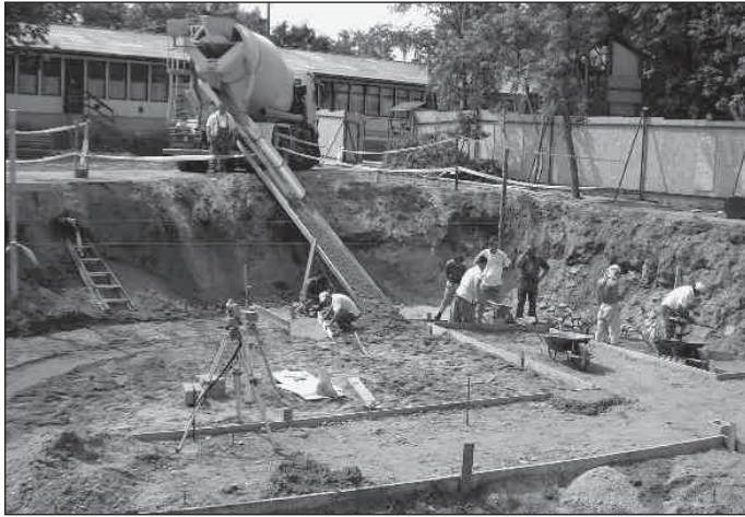
Az új épület alapozása
