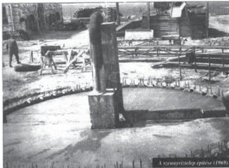
A szennyvíztelep építése (1969)
