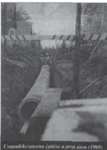
Csatornaépítés a pesti úton (1968)
