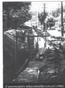
Csatornaépítés talajszint-süllyesztéssel (1968)
