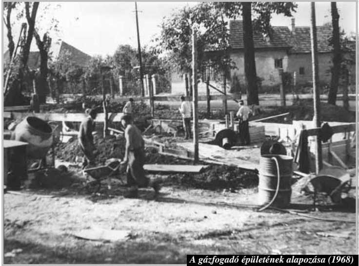
A gázfogadó épületének alapozása (1968)
